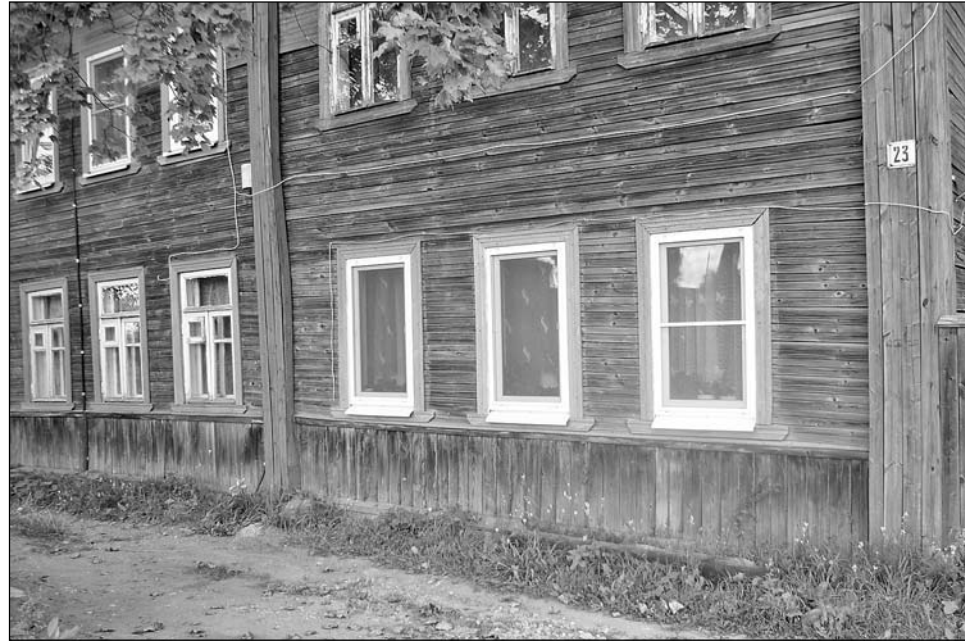
Ремонт фундамента этого дома запланирован на следующий год
