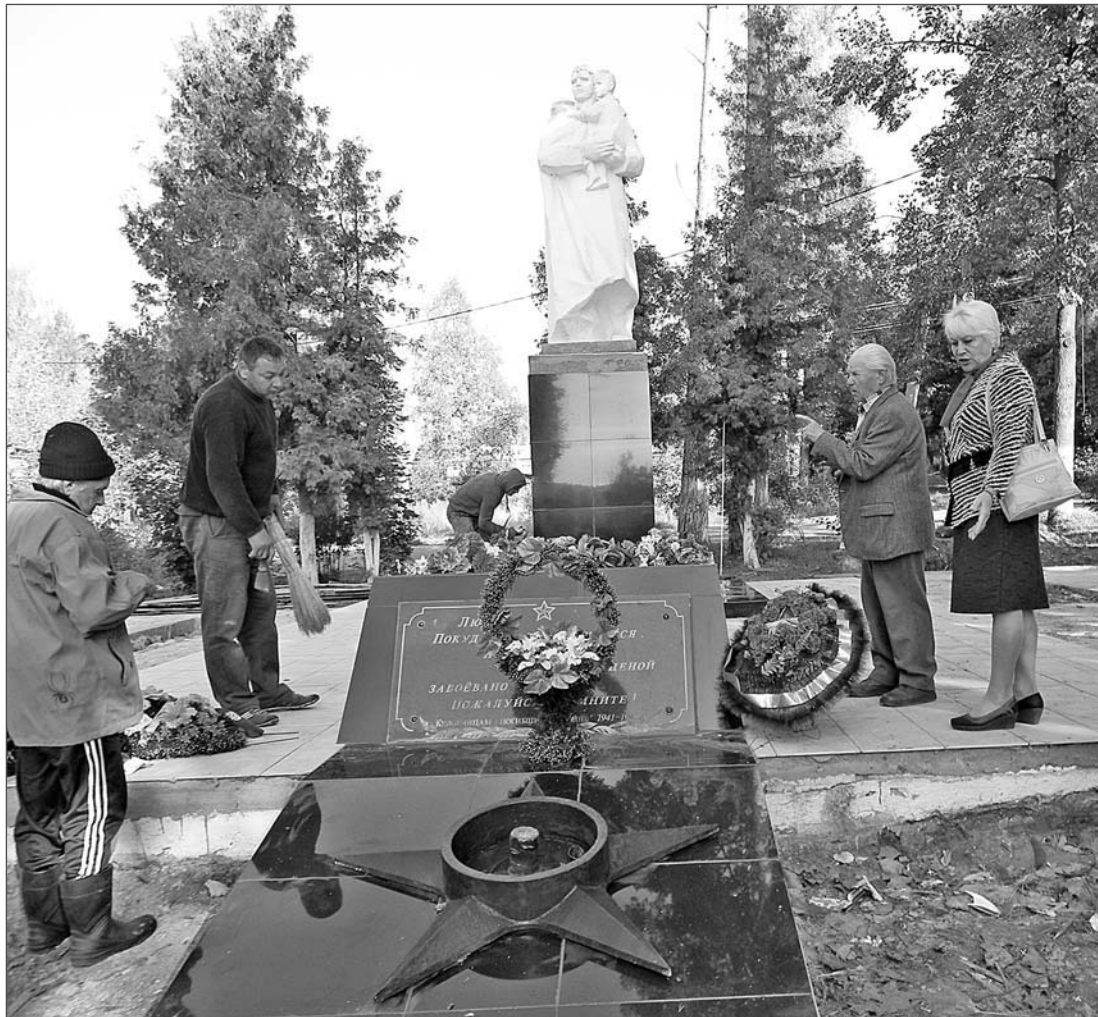
Ремонт памятника воину-освободителю в Кулотине практически завершён
